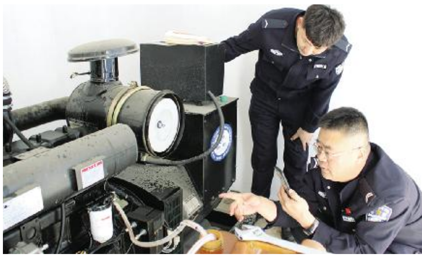
3月11日,鄂尔多斯市公安局交管支队沿黄公路大队辖区停电,为了不影响机关民警正常工作,该大队设施保障中队民警全力以赴做好后勤保障工作,确保各部门工作运行正常。图为该中队民警及时维修发电机,开启自主发电模式。李亮 张梓柯 摄
