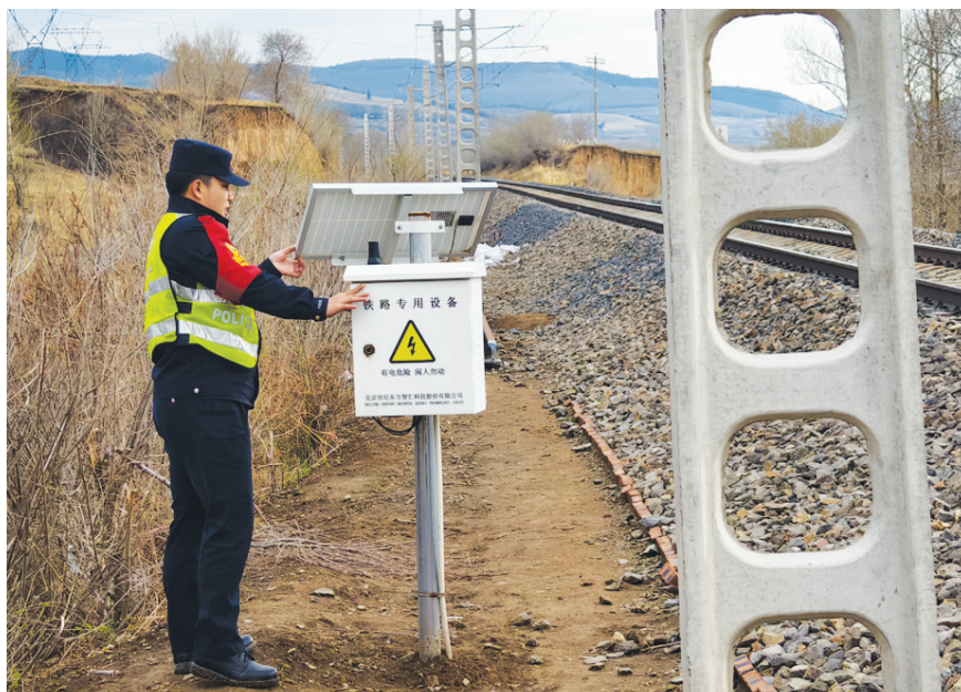
近日,通辽铁路公安处四合永车站派出所开展了线路隐患排查整治工作,督促铁路部门及时整改隐患,筑牢线路安全屏障,确保铁路运输绝对安全。张杨摄
